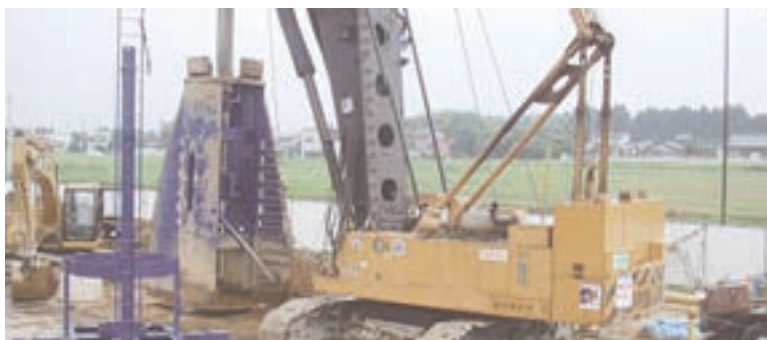
専用スライム処理機使用状況 (軸径 \phi 2,100、拡底径 \phi 4,700)
