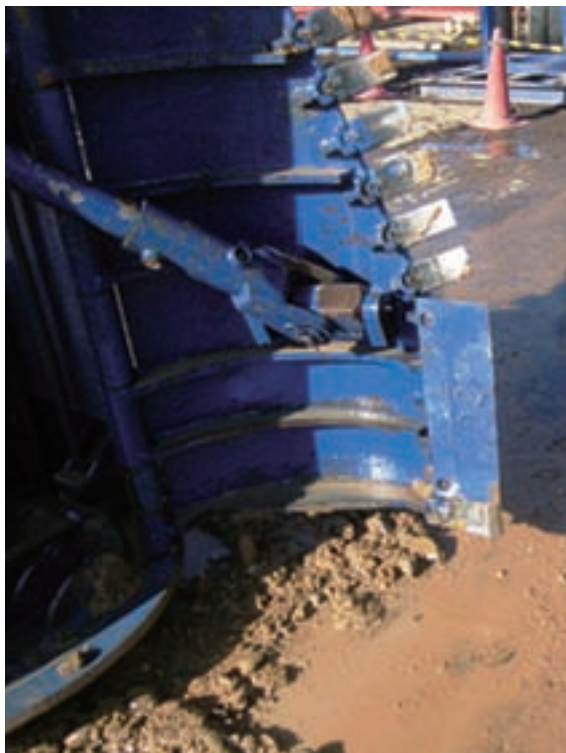
底ざらい用スクレーパ取付状況
