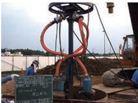
専用スライム処理機使用状況 (軸径 \phi 2,100、拡底径 \phi 4,700)
