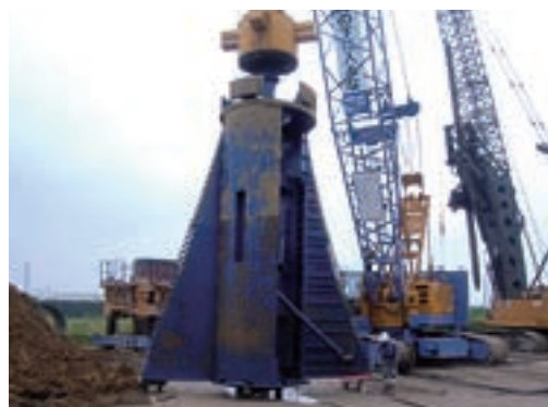
オールケーシング工法による拡底部掘削状況 SY-2147/バケット(施工径φ2300-4700)
