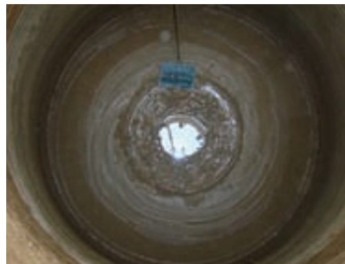
底ざらい状況(拡底径 \phi 4,700)
